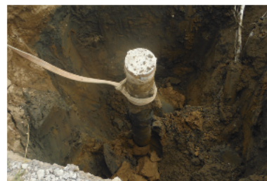
施工事例①
